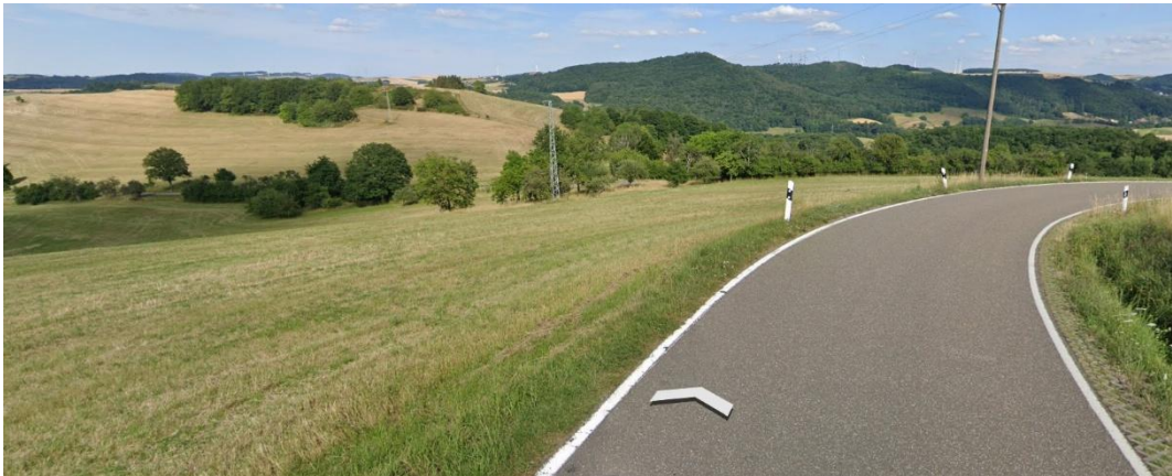
Abbildung 8: Blick von der K 43 eingangs der Serpentine in Richtung des Plangebiets; Quelle: Google Street View
