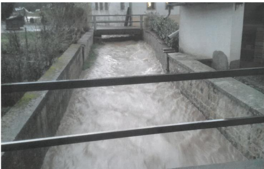
Abb. 31: Hochwasserabfluss im Perlebach bei Starkregen im Juni 2018 (Bild zeigt nicht den Höchststand), Foto: Ortsgemeinde
