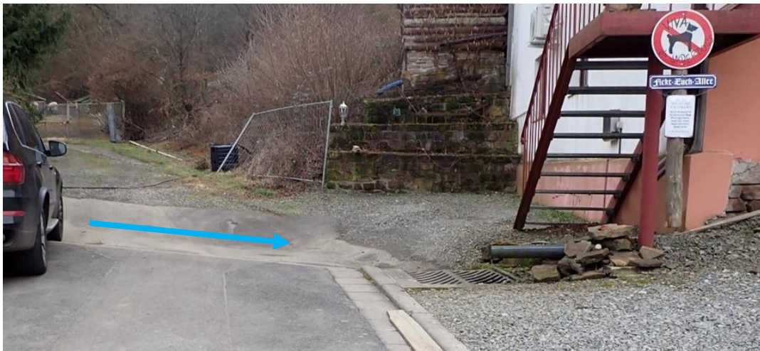
Abb. 86: Übergang des Seitengrabens auf die Verrohrung im Winhofweg
