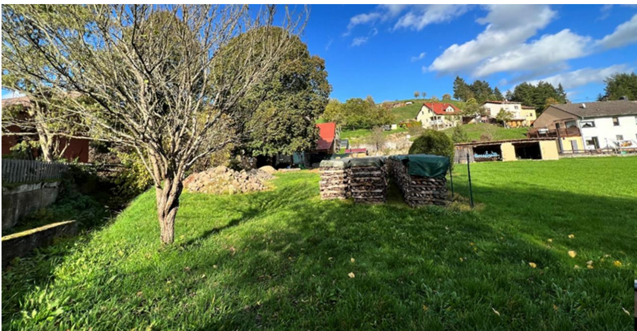
Abb. 80: Geländeauffüllung neben dem Perlebach
