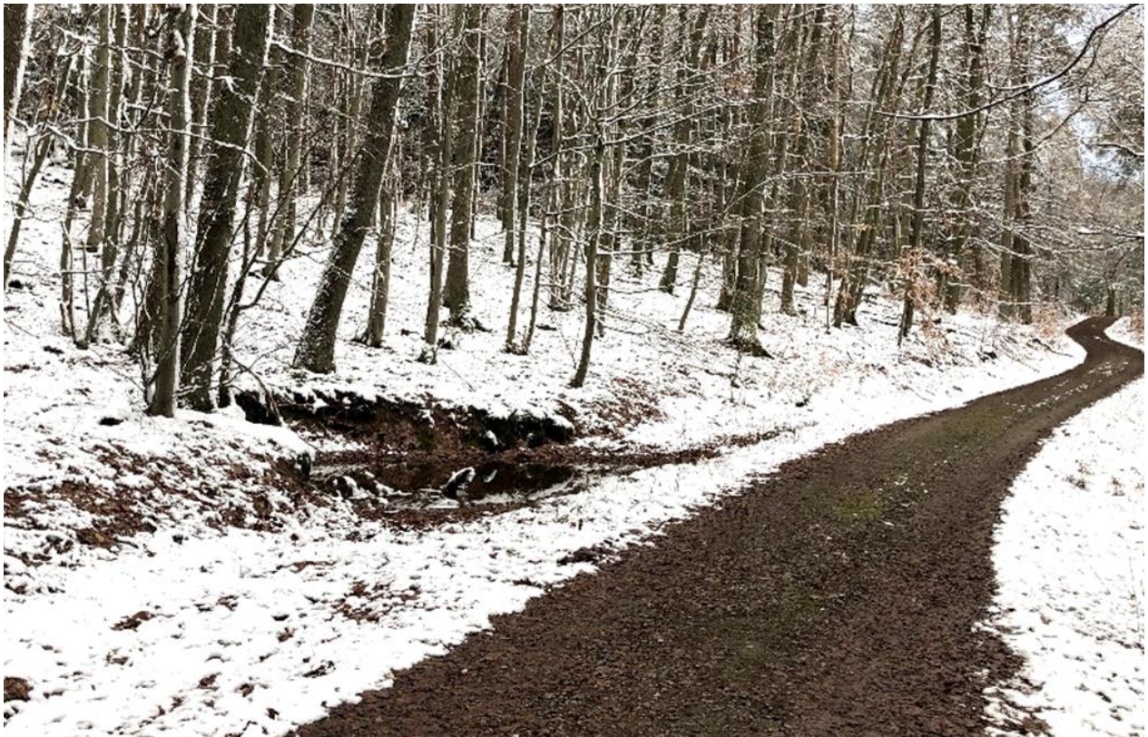
Abb. 12: Beispiel für einen Kleinrückhalt als Rückhalte- bzw. Sickermulde neben einem Waldweg
