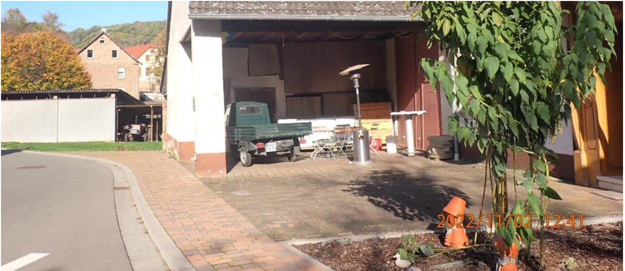
Abb. 88: Überflutungsgefährdung in der Straße „Damm“
