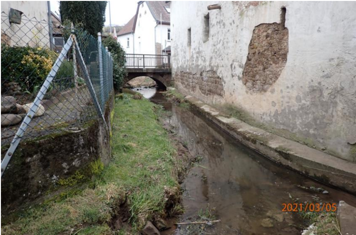
Abb. 58: Brücke Hauptstraße über den Perlebach
