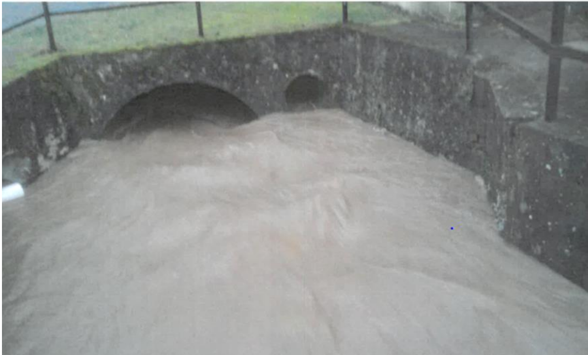
Abb. 32: Durchlass der Straße Oberdorf bei Starkregen in 06/2018, Foto: Ortsgemeinde
