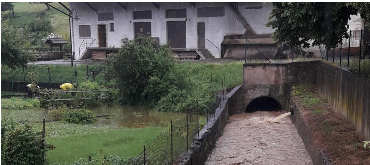
Abb. 42: Hochwasser im Perlebach im Juni 2021, Foto: Verbandsgemeinde
