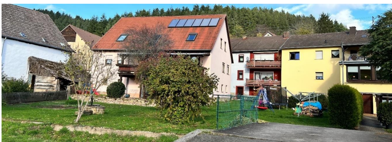
Abb. 48: Überflutungsgefährdete Bebauung zwischen Straße Unterdorf und Perlebach
