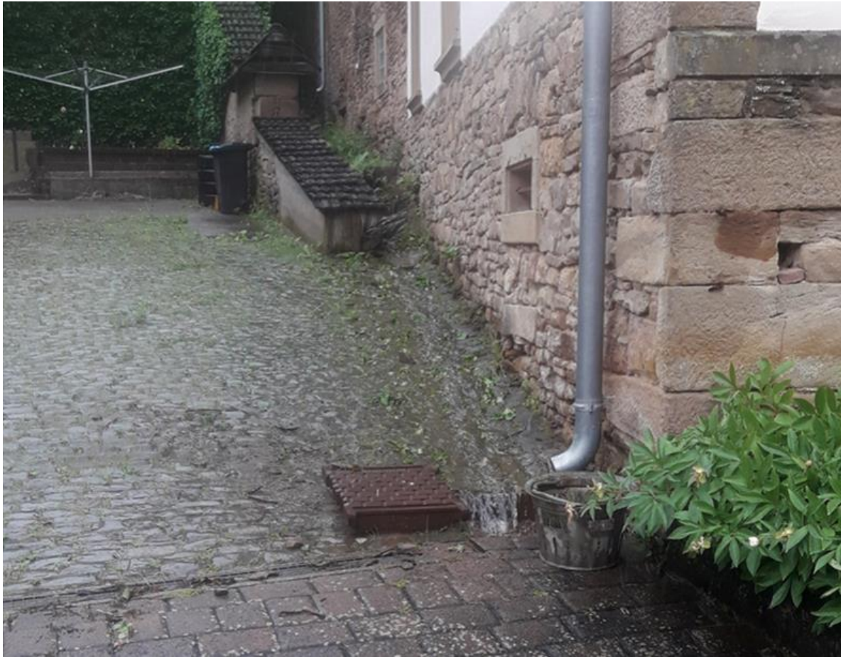
Abb. 46: Abflusssrinne zur Straße Unterdorf bei Regen
