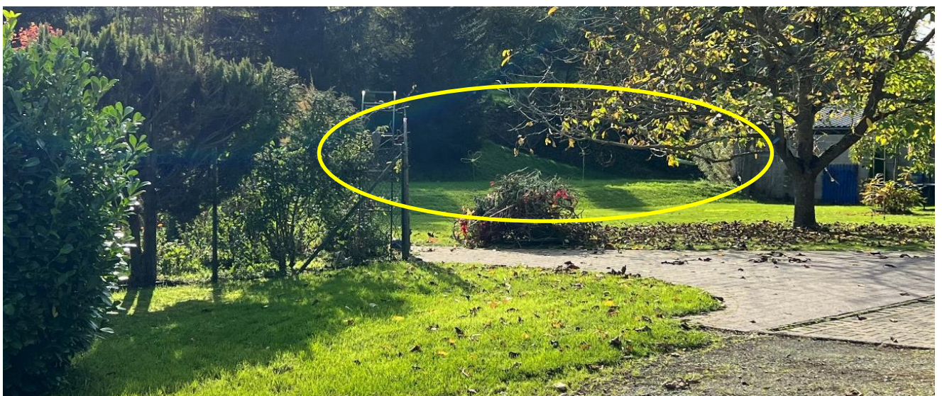
Abb. 71: Private Verwallung entlang des Jeckenbachs Örtliches Hochwasser- und Starkregenvorsorgekonzept Kappeln
