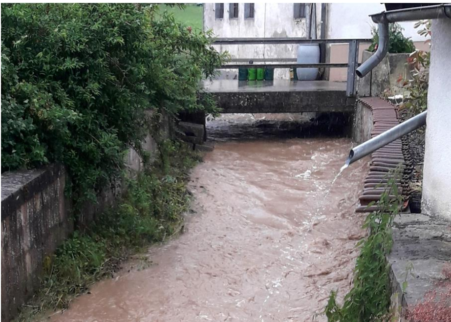
Abb. 9: Beispiel für Dachentwässerung in den Bach in Kappeln
