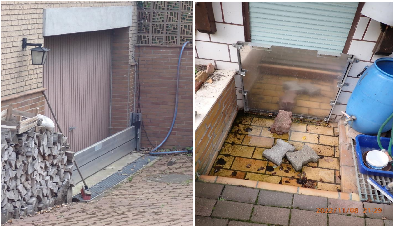
Abb. 19: Dammbalkenverschluss (links) und Schott (rechts)
