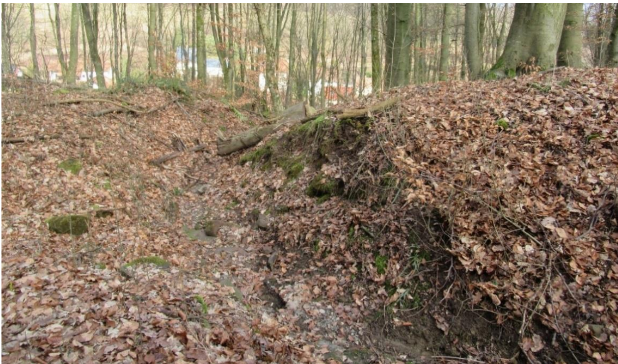
Abb. 11: Beispiel für Abschlag von Oberflächenwasser von Waldweg in die Fläche
