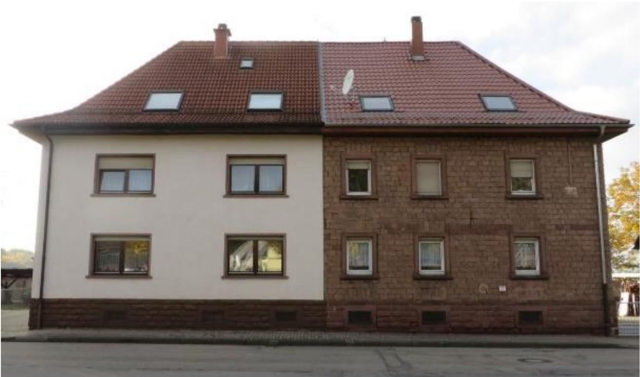
9 Negativbeispiel, wo historische Fassadenelemente (Gewände) durch Wärmedämmung überdeckt wurden
