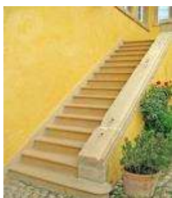
Abbildung 53: Beispiel für eine Sandstein Außentreppe
