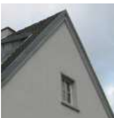
Abbildung 4: Ortgang verschalt
