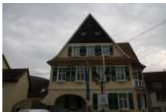
Abbildung 11: Beispiel für historische Bauweise
